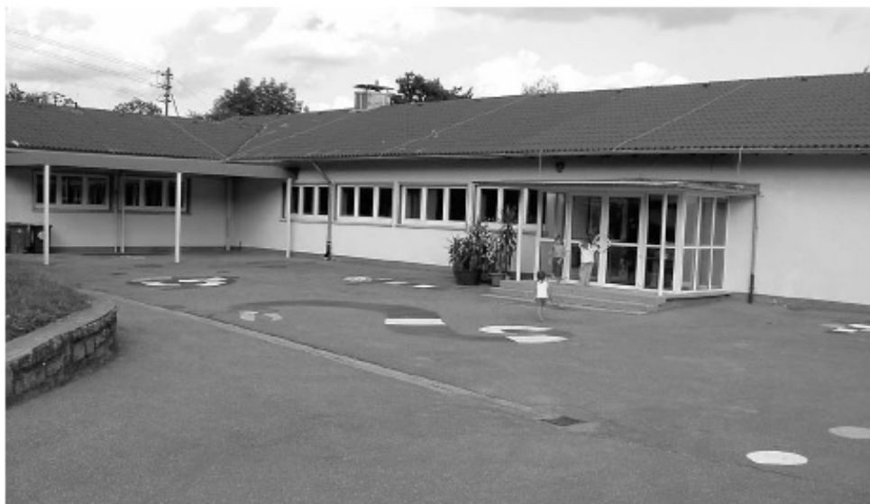
Treffpunkt Staufenberg: Das ist der Pausenhof der Grundschule heute.
