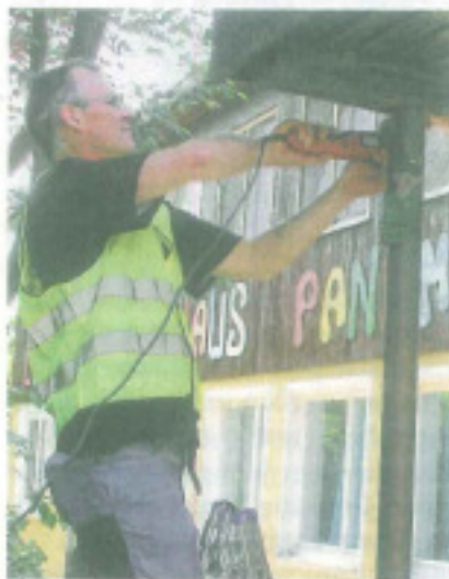
Der marode Eingang: Mit der Flex werden Pfosten abgetrennt. Fotos: Kinzinger
