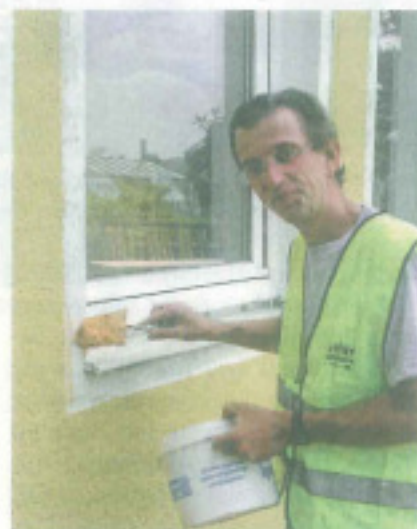
Die Außenfassade am Panamahaus erhält einen neuen Putz und Anstrich.
